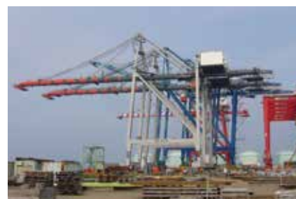
港湾コンテナクレーン
